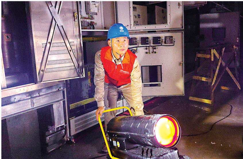
大唐世家小区,电力设备全部泡水,抢修人员用烤灯烘干供电设备
