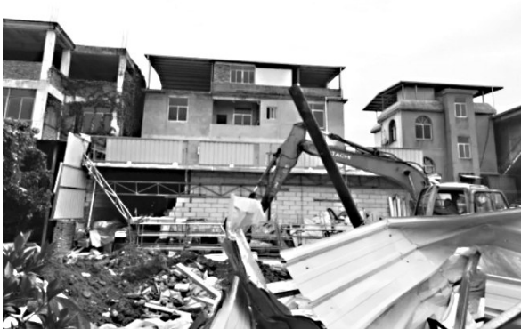
拆除违建厂房现场
