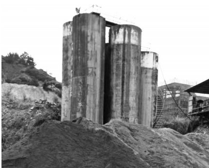
设施被查处 石子场无覆盖防尘抑尘
