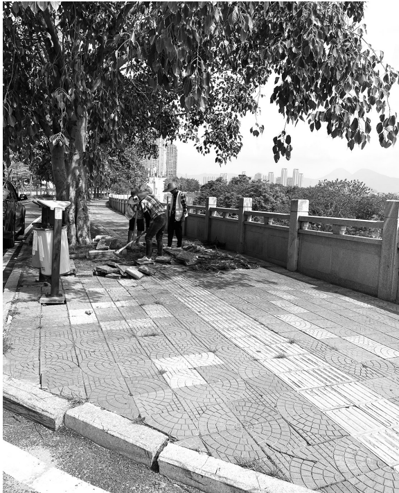
工作人员修复人行道
