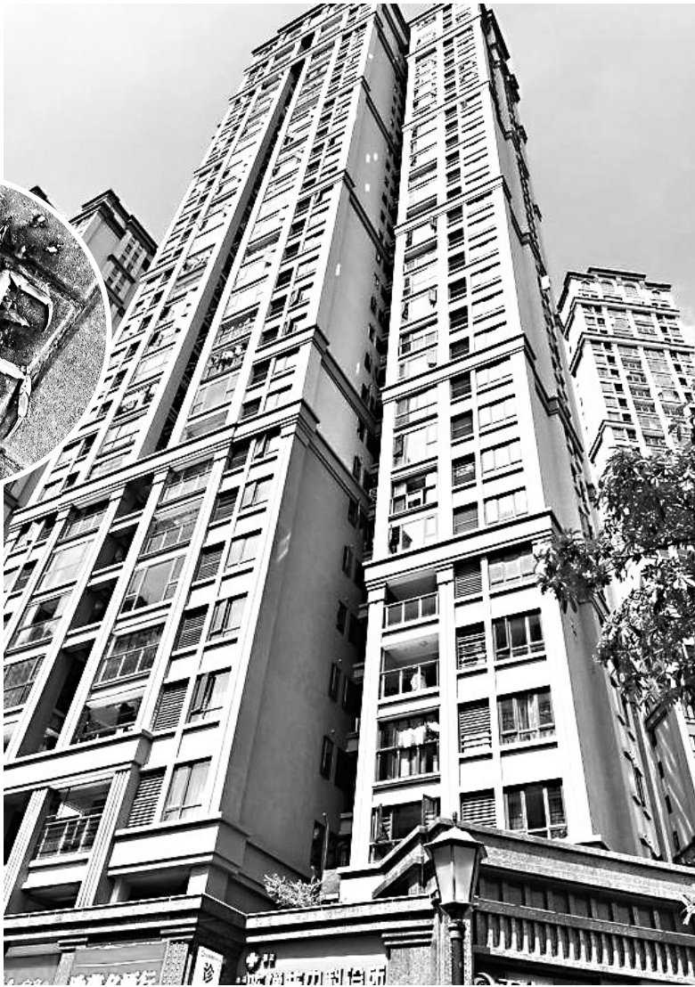
发生螃蟹掉落情况的十号楼,该楼栋二层设有空中花园
