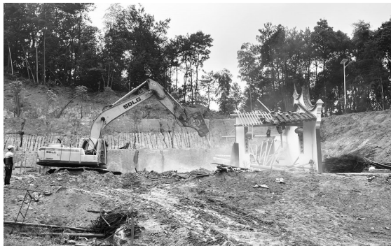
中房镇拆除违建
