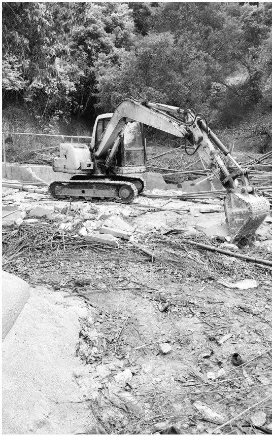
松山镇拆除违建养猪场
