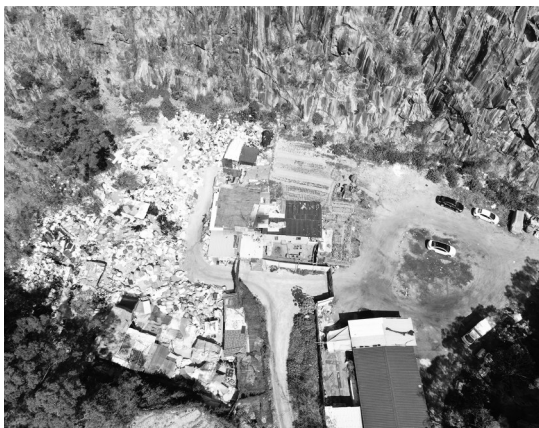
整治前的沿山片废品收购场
