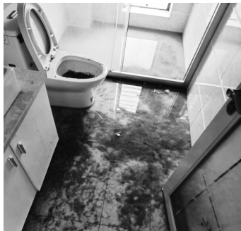
卫生间马桶倒灌,污水满地
