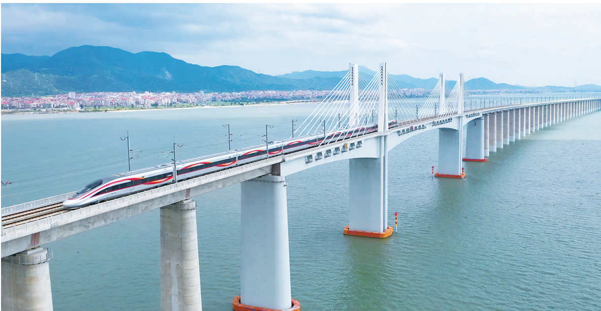
复兴号智能动车组行驶在福厦高铁湄洲湾跨海大桥(李响/摄)
