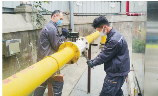
镇工业用户接入燃气管道 华润燃气工作人员为龙田
