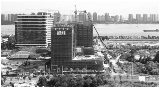
项目主体结构已竣工封顶
