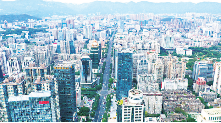
中建海峡承建的福州市五四路精品工程建筑群
