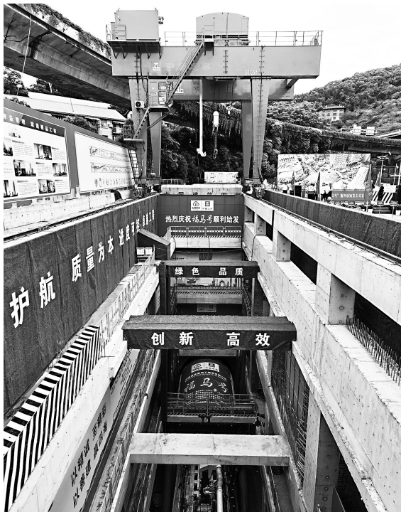
9日,福州地铁2号线东延线盾构机“福马号”顺利始发
