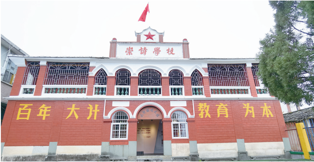
崇诗学校为混合结构两层洋房
