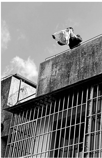
工人从楼顶直接往下扔垃圾
