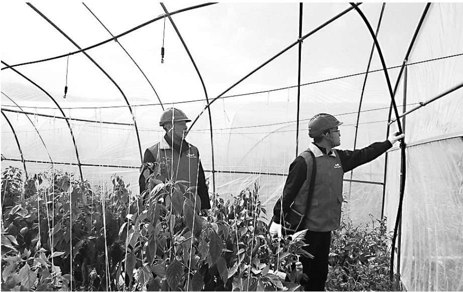
现场排查大棚用电情况
