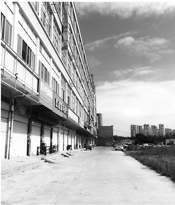
惠东工业园区部分基础设施存在老化、破损等现象
