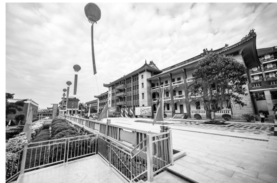
修缮一新的新华楼
