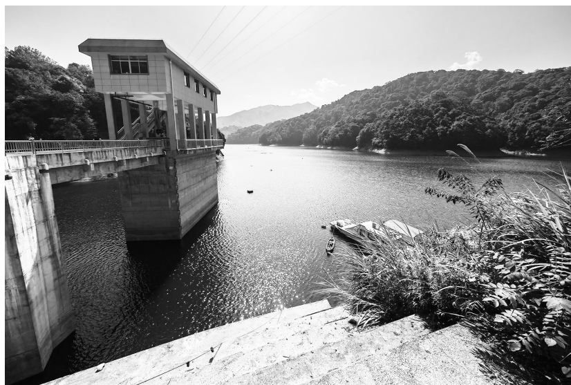
三明市区饮用水水源地东牙溪水库的水质自动监测站
