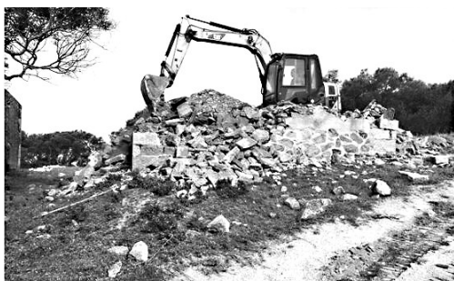
一处违建被拆除
