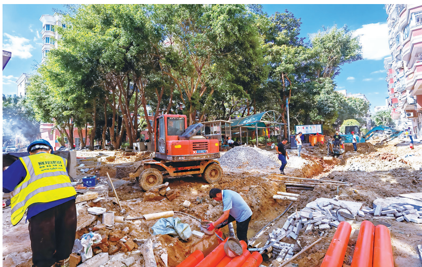
湖心苑小区改造现场
