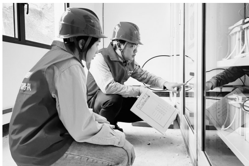
电力员工在施工现场
