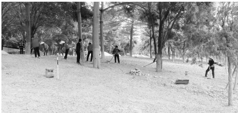
新增打卡点阳光大草坪正在施工中
