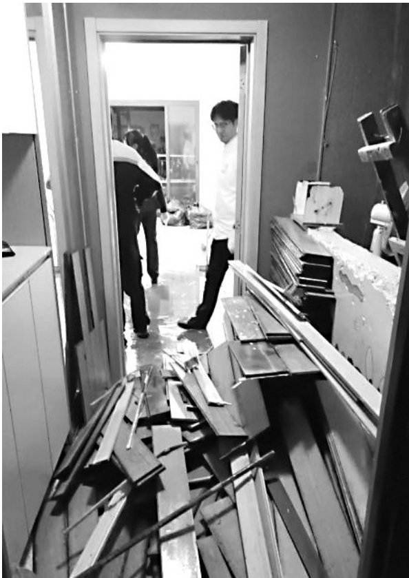
客厅的木地板被撬下
