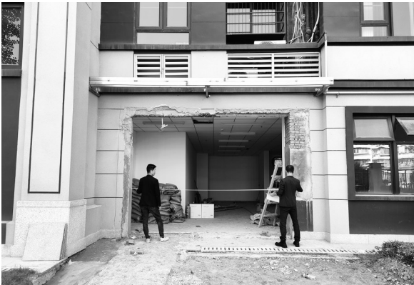
装修现场已暂停施工
