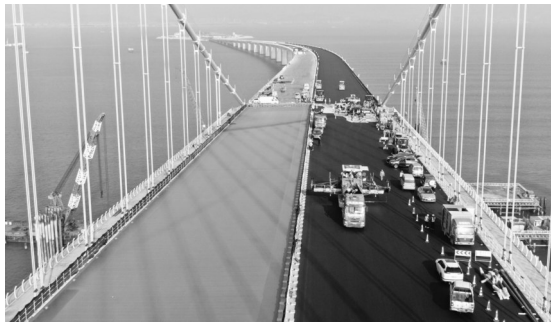
工人在深中通道伶仃洋大桥进行路面铺装工作
