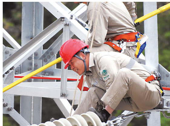
陈国信在输电塔上开展线路检修(受访者提供)
