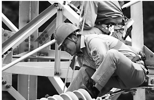
陈国信在输电塔上开展线路检修(受访者供图)
