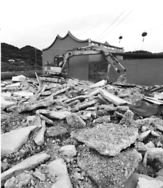
福清龙江街道拆违现场
