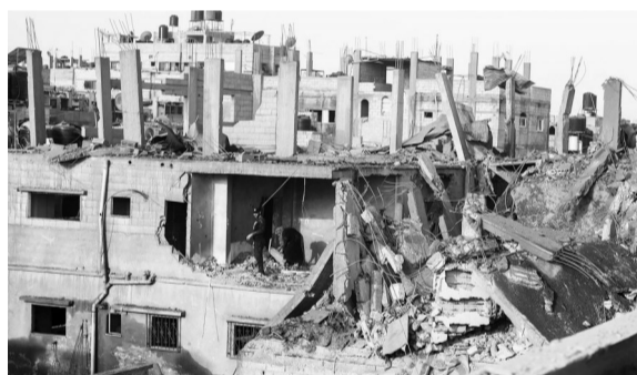
6日,在加沙地带南部城市汗尤尼斯,巴勒斯坦人查看遭以军空袭后的建筑废墟
