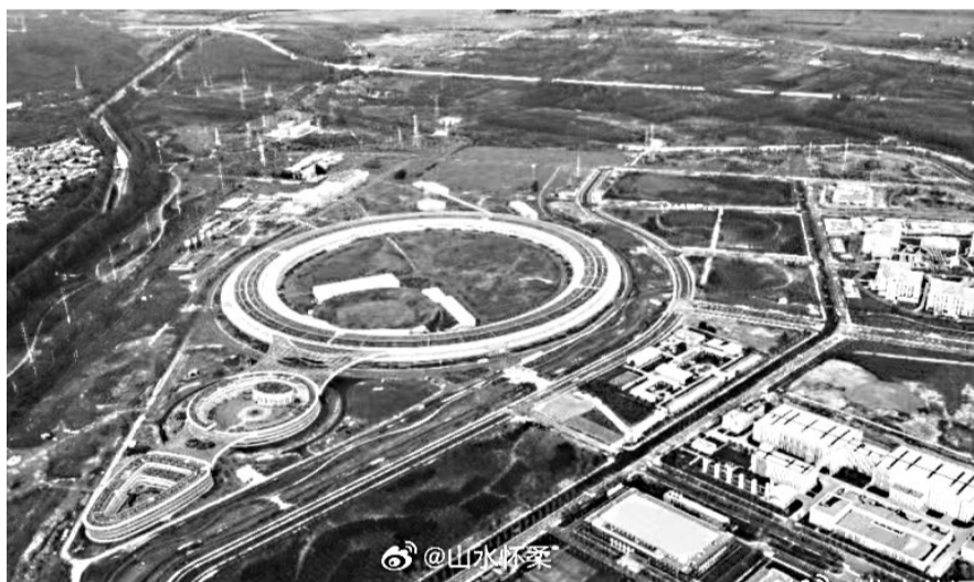
国家重大科技基础设施项目高能同步辐射光源(HEPS)
