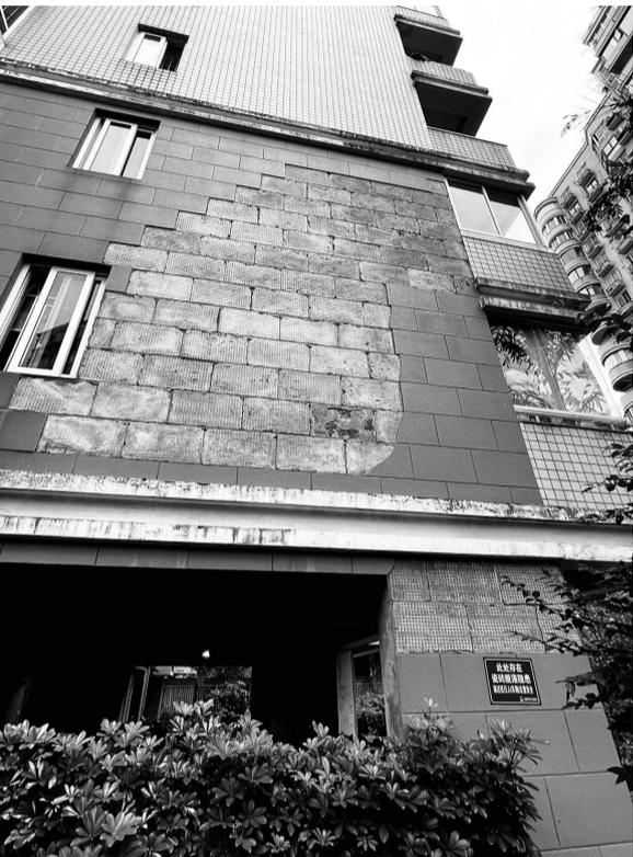
14号楼外墙瓷砖大片脱落
