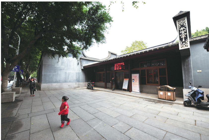
林则徐纪念馆出口处的墙体为深灰色
