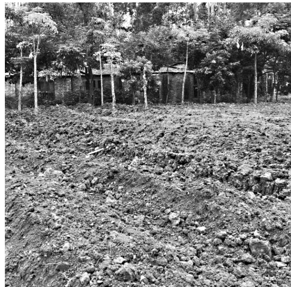
透堡镇拆除违法占用耕地违建
