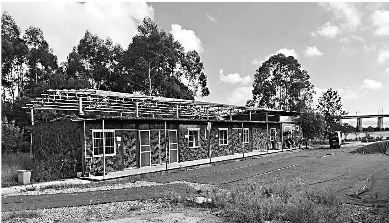
拆除私自搭建的建筑
