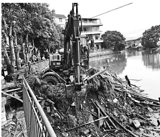
琯头镇拆除占用河道违建
