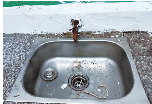
厨房水龙头严重生锈
