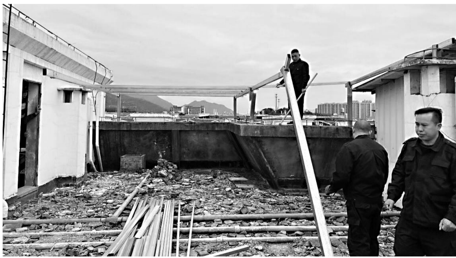
高层建筑屋顶平台违建被拆除
