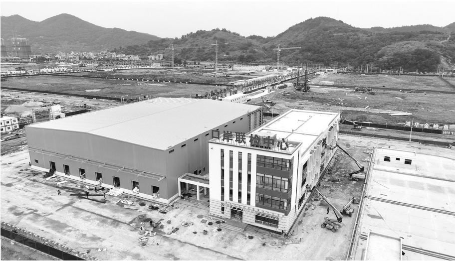
福州(连江)国家远洋渔业基地口岸联检中心工程主体结构全部完工
