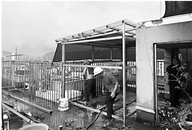
顶楼一处违建被拆除
