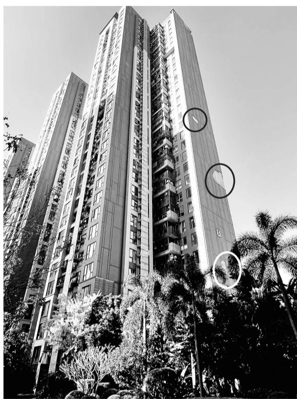
5号楼东侧,多处墙面瓷砖脱落
