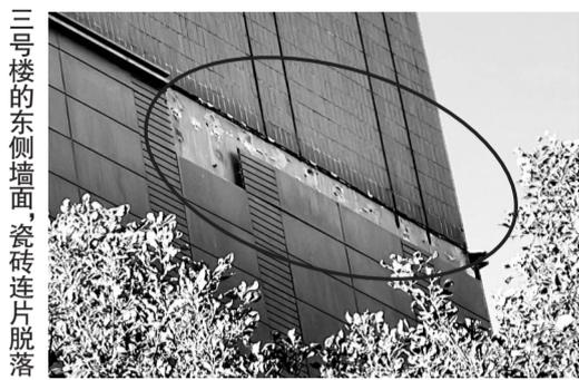
3号楼的东侧墙面,瓷砖连片脱落
