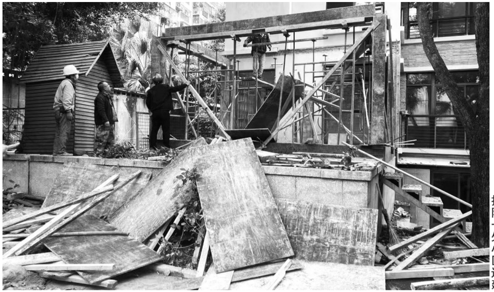
拆除一处小区违建
