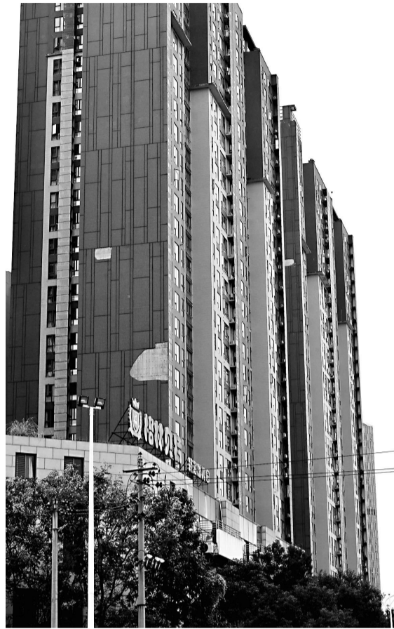
闽侯阳光城领海小区外墙脱落，物业已申请启动维修资金
