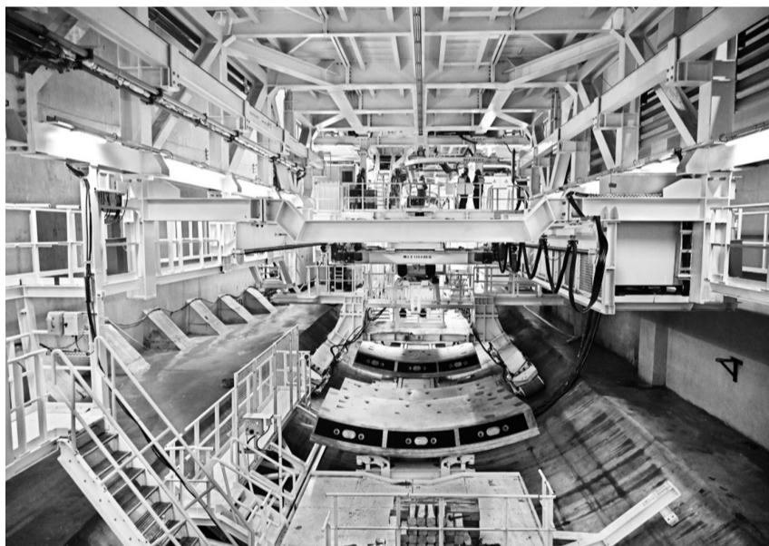
12月30日,建设者在青岛胶州湾第二隧道工程南线主线隧道盾构掘进现场作业
