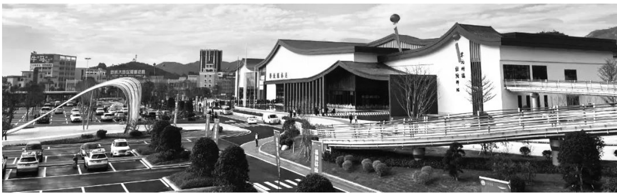
综合服务楼以“新骑楼”的形式体现闽南文化的传统型、延续性
