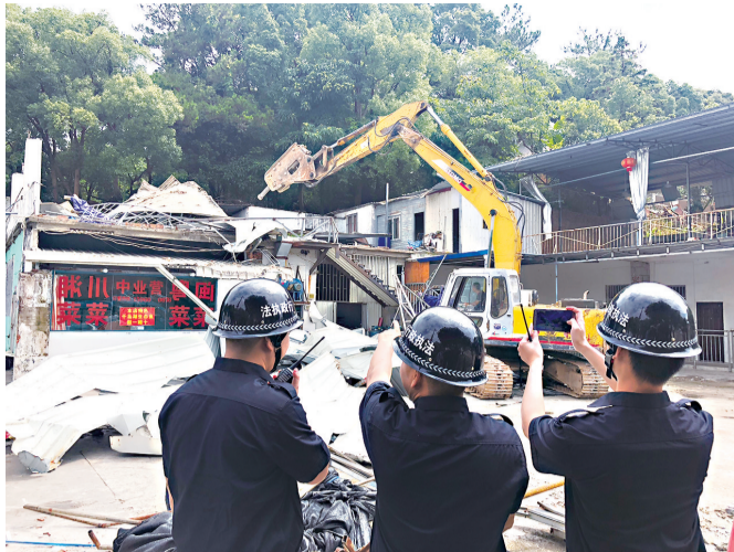
执法人员对违建进行拆除
