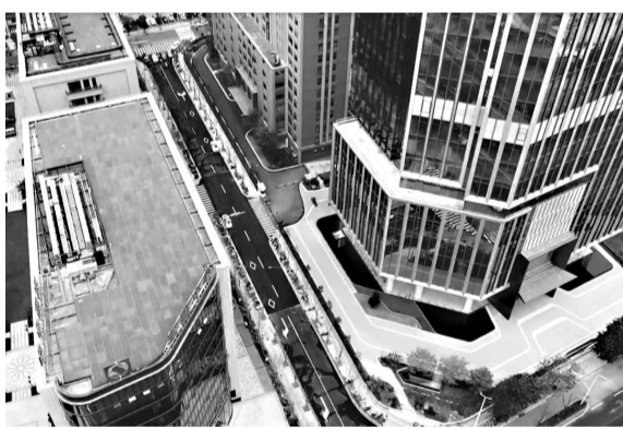
高新区科技支路二期道路
