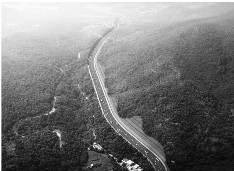
万虹路(马甲新庵岭—罗溪客运站)道路改造提升工程
