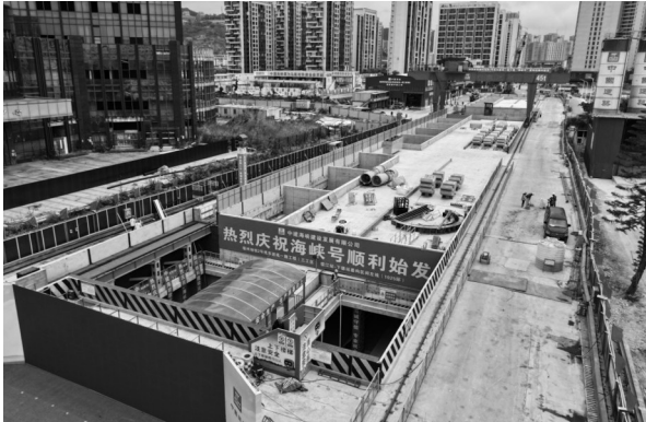
福州地铁2号线东延线一期工程下德站“海峡号”盾构机始发处(新华/图)
