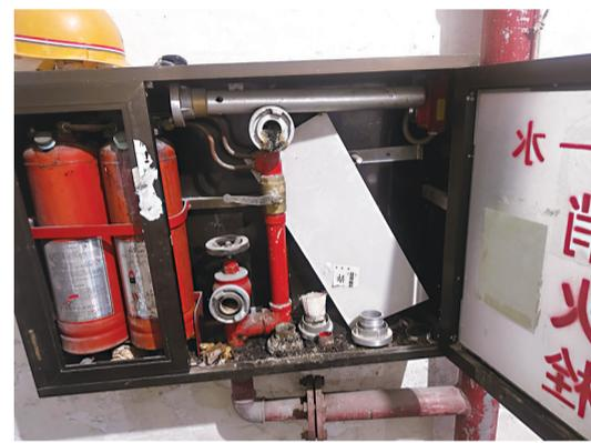
电动车停放处旁的消火栓已经损坏
