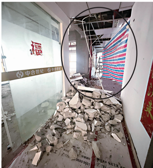
隔断通道的墙(画圈处)已被拆除
