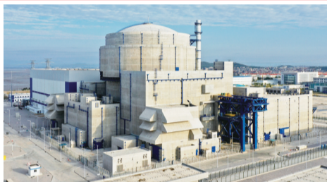
“华龙一号”示范工程福清核电6号机组
